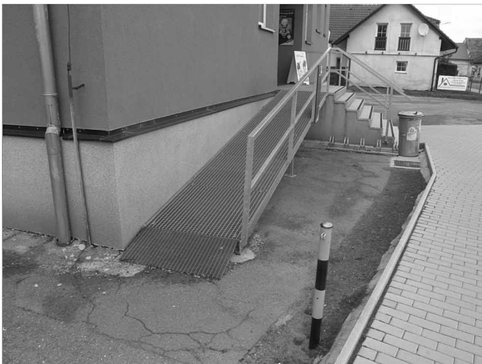
F14 – bezbariérový vstup do kulturního domu
